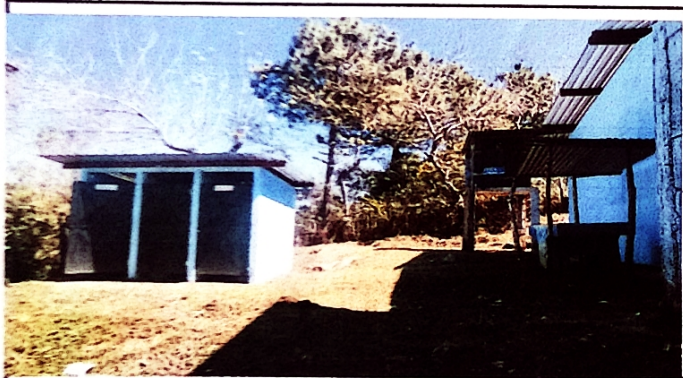
Foto 3: sistema de coptacion de agua
