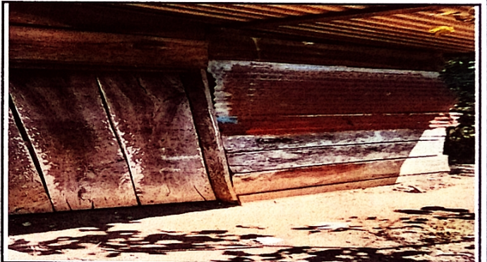
Foto 4: repacion y ampliacion de area cocinas
