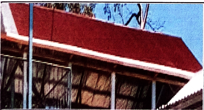
Foto 5: sustitucion de laminas y costaneras
