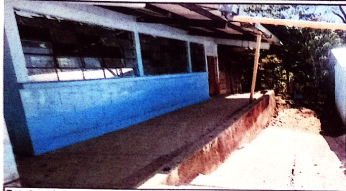
Foto1: colocacion de barranda
