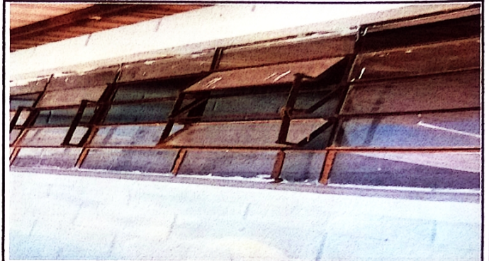
Foto 2: sustitucion de vidrios
